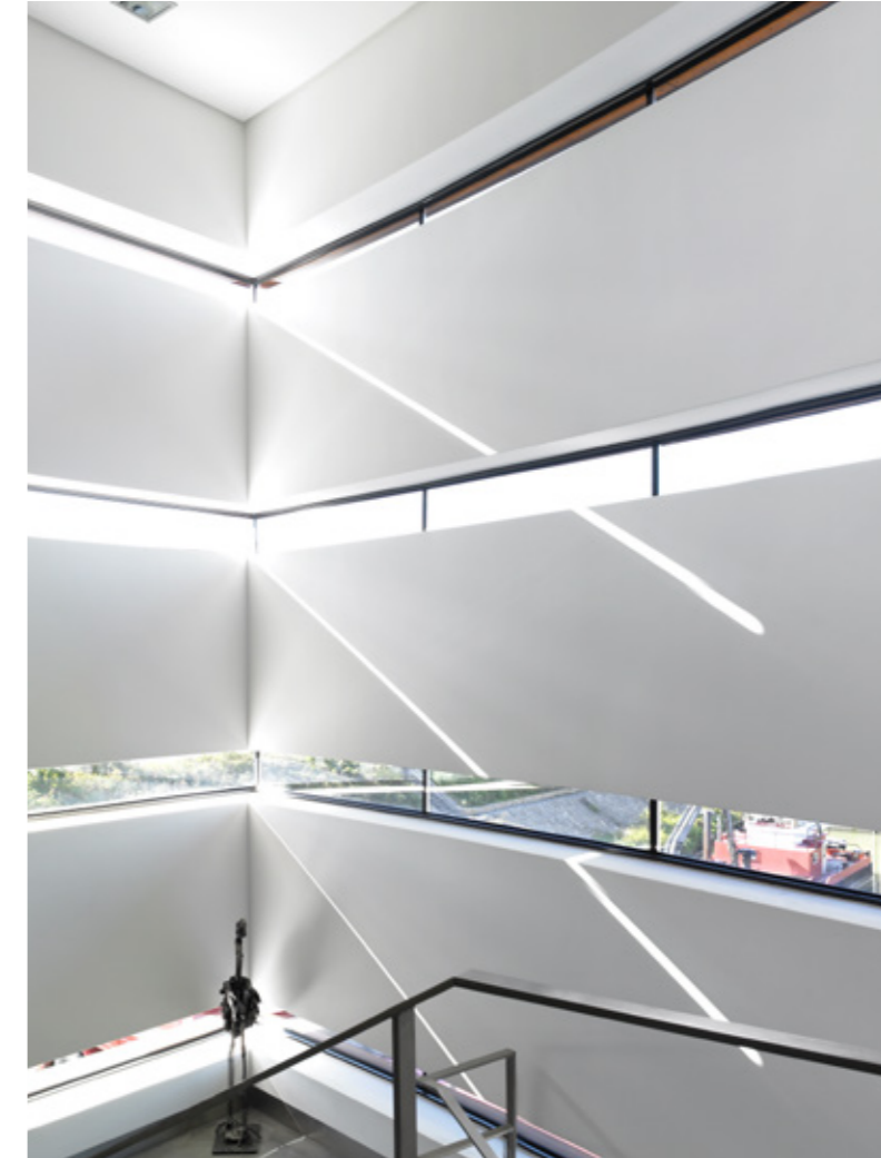
Bâtiment "Luxport" au port de Mertert
